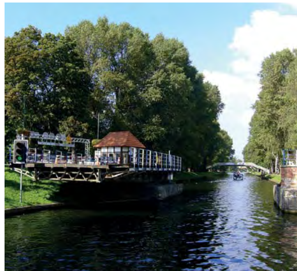
Drehbrücke in Gizycko
