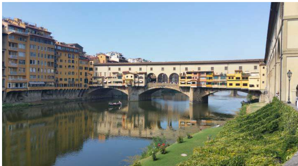
Eine der berühmtesten Brücken in Italien: Die mittelalterliche Ponte Vecchio in Florenz
