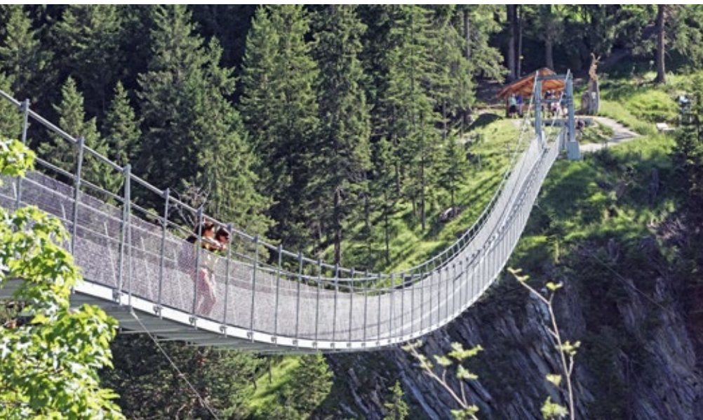
Österreichs längste und höchste kostenlos begehbare Hängebrücke führt über das Höllenbachtal
