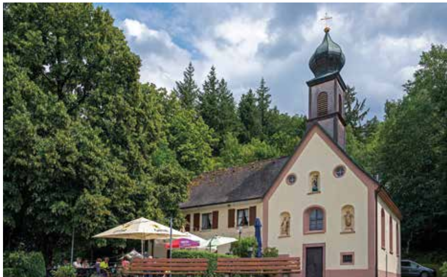
Die Pilgerstätte und Pilgergaststätte St. Laurentius auf dem Giersberg
